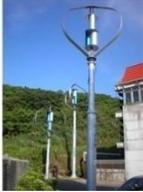
L'installazione di turbine da 3kW in torri da 3 o 4 generatori presenta una soluzione intelligente ed innovativa che consente di ottimizzare gli spazi senza sacrificare la capacità produttiva del sistema.
